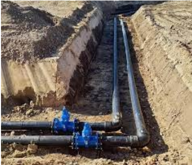
Foto van bronnet leidingen in constructie
