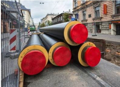
Foto van warmtenet leidingen in constructie
