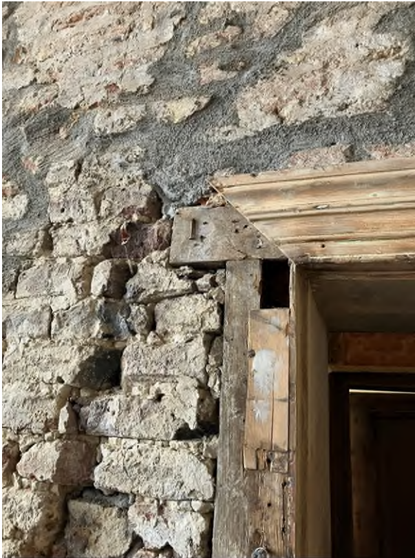
Foto: bovenhoek architraafbetimmering binnen kozijn tijdens herstelwerkzaamheden
