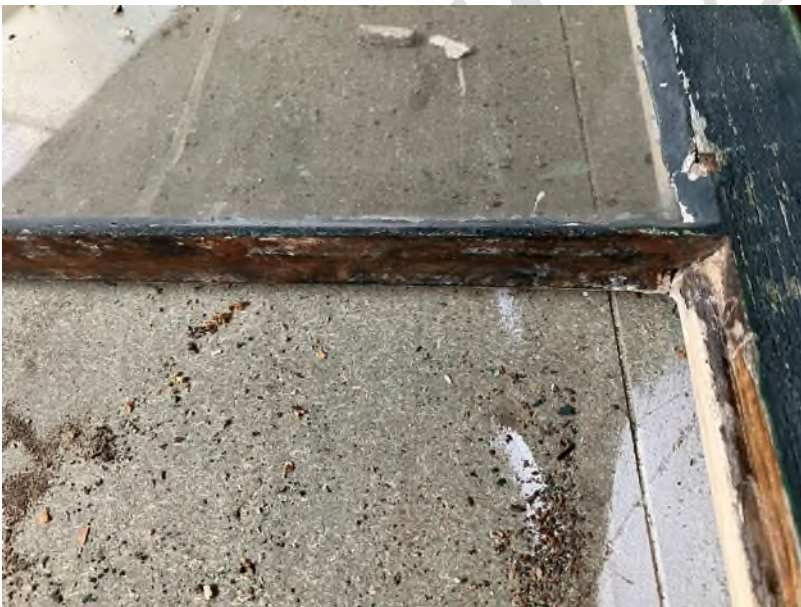
Foto: in houten ramen zijn vaak metalen roeden te vinden. Deze waardevolle onderdelen zorgen voor een architectonisch kwaliteit in de gevels dat behouden dient te worden.
