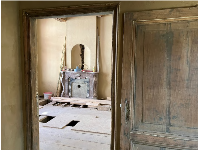
Foto: schouw geïntegreerd in de verbouwingsplannen.
