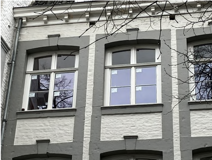
Foto: pas geplaatst dun isolerende beglazing
