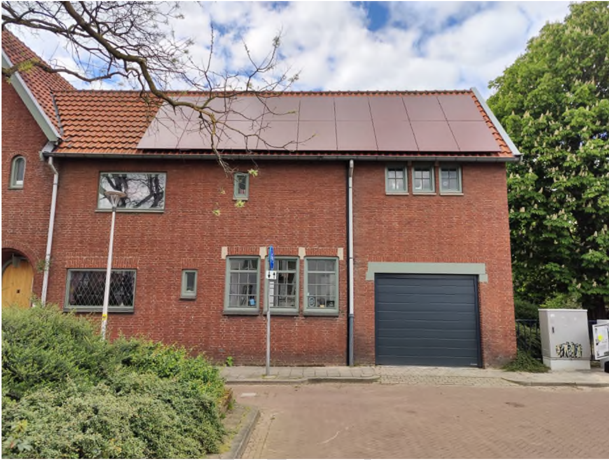
Foto's: toepassing van rode zonnepanelen op een monument in Heerlen
