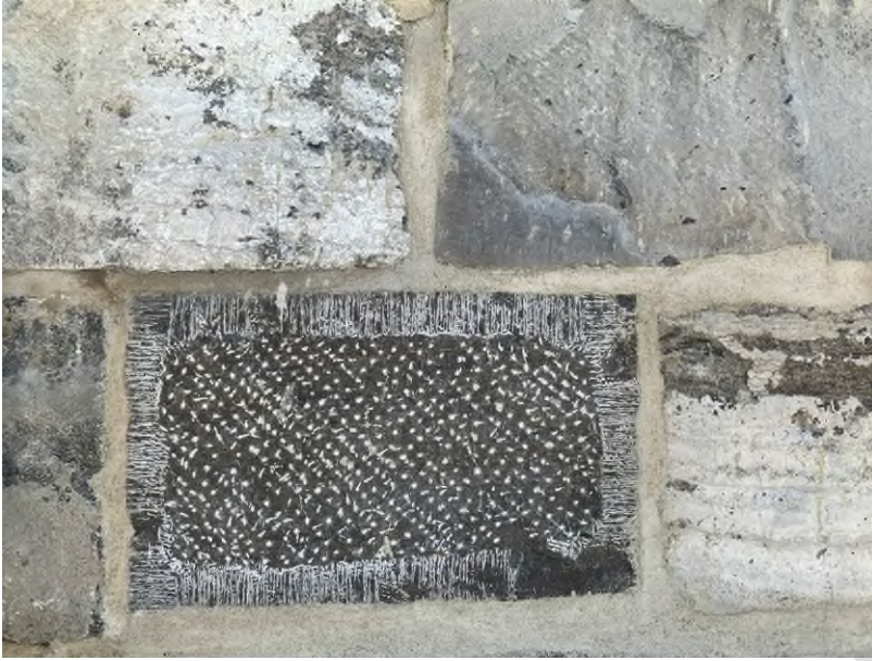
Foto: hardstenen muur waarbij één blok is ingeboet en afgewerkt volgens de oude technieken
