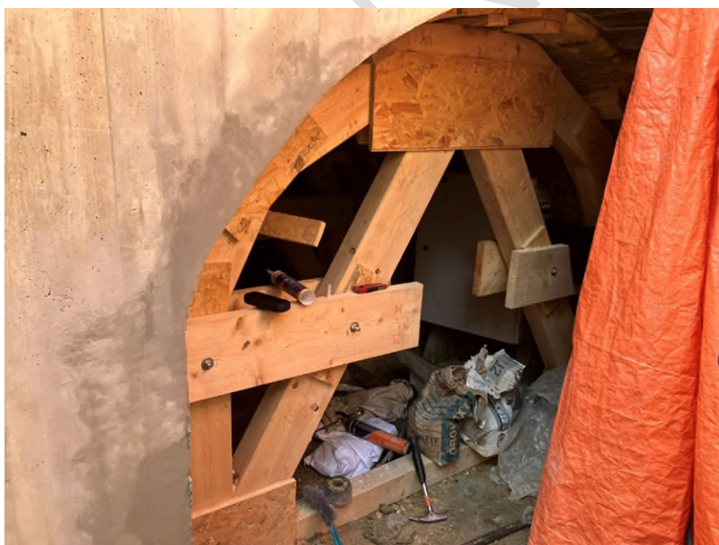
Foto: houten formeel tijdens herstelwerkzaamheden aan een kelder.
