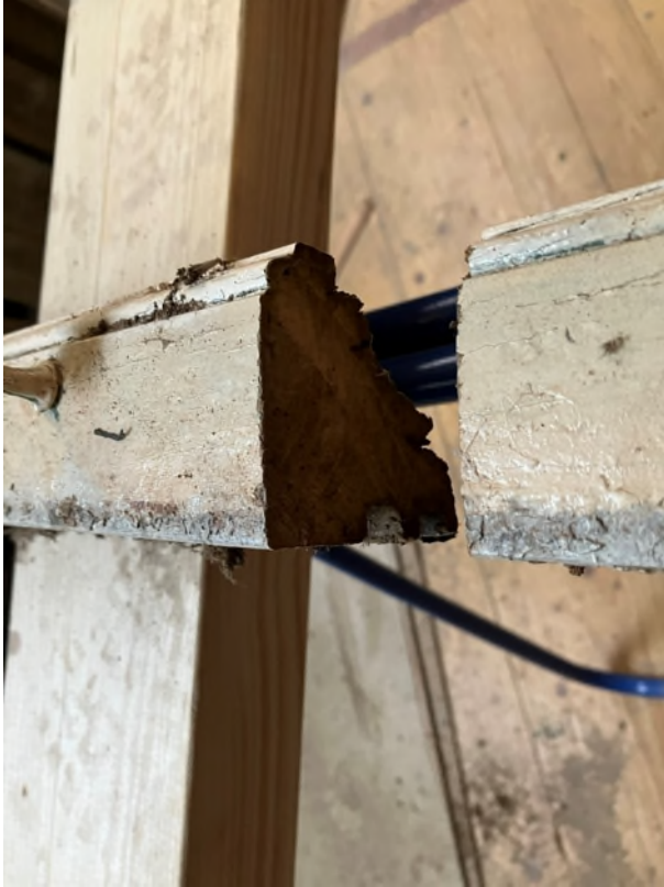
Foto: doorsnede houten onder regel raamvleugel
