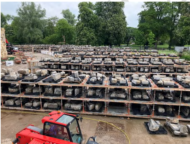
Foto: de stenen zijn duidelijk gecodeerd tijdens de uitvoeringswerkzaamheden zodat ze teruggeplaatst kunnen worden op de oorspronkelijke plaats
