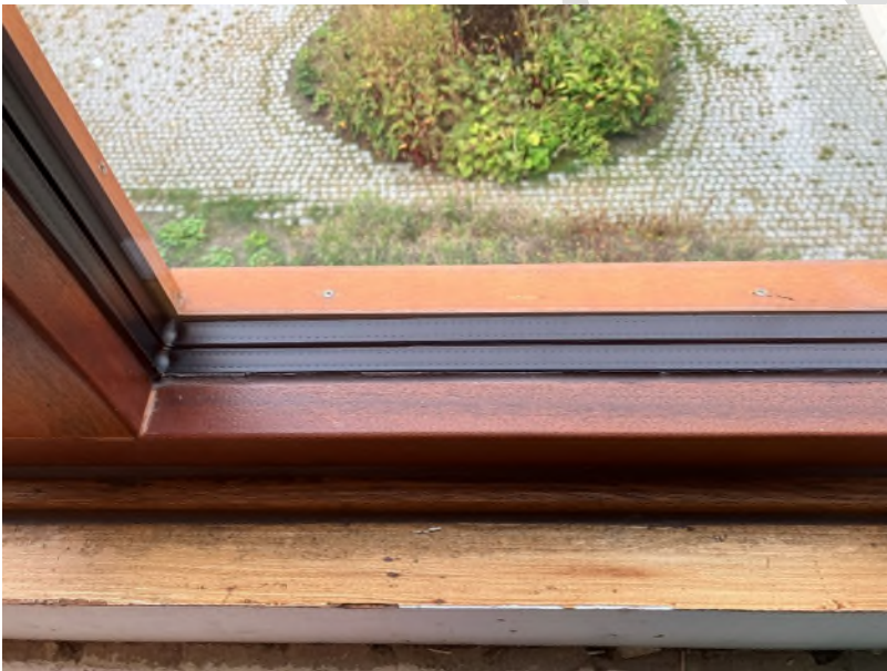
Foto: voorbeeld zwarte afstandhouders toegepast in triple glas
