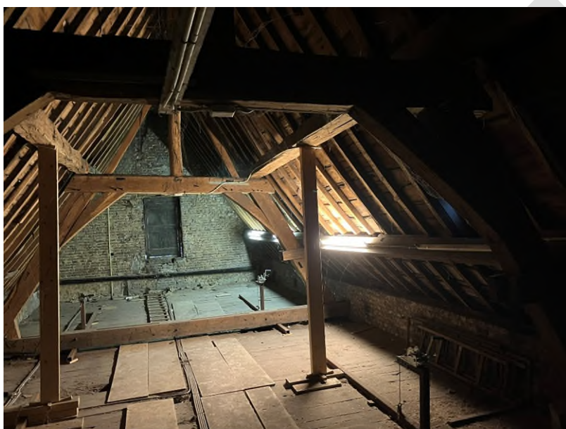
Foto: houten kapconstructie
