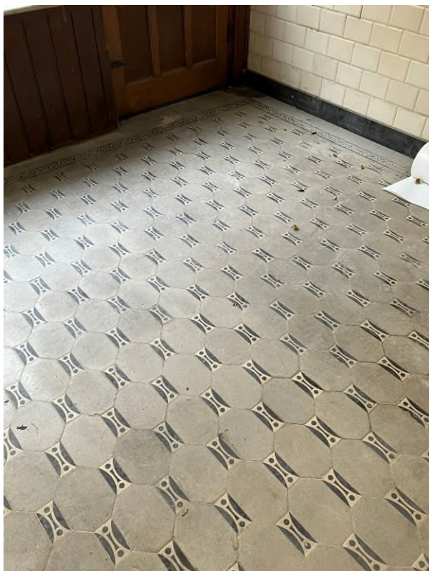
Foto: tegelvloer van voormalige winkel
