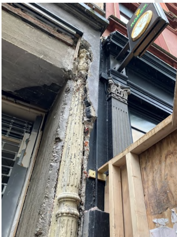
Foto: gietijzeren kolom als versiering van een winkelpui
