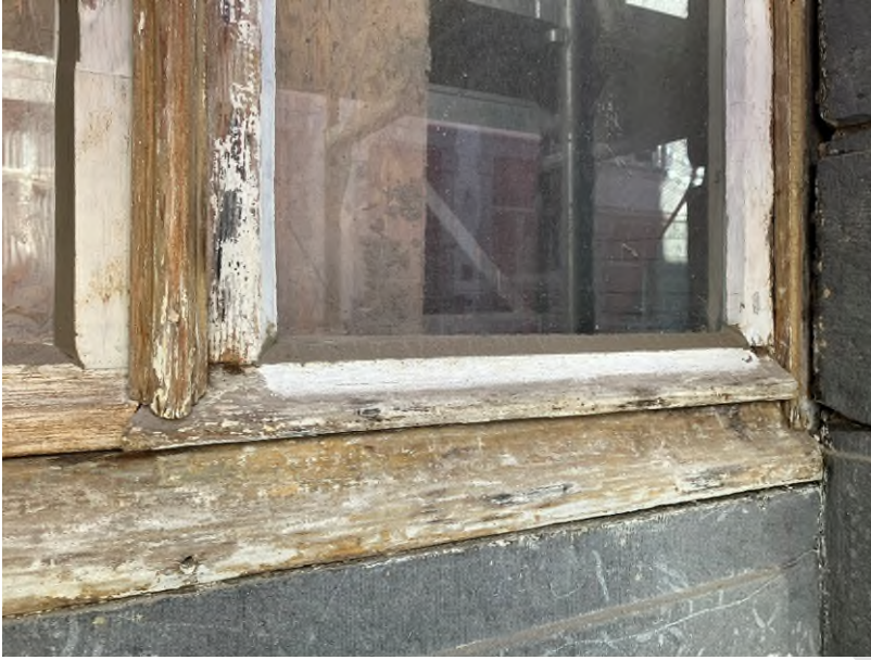
Foto: houten raam en raamdorpel tijdens uitvoeringswerkzaamheden
