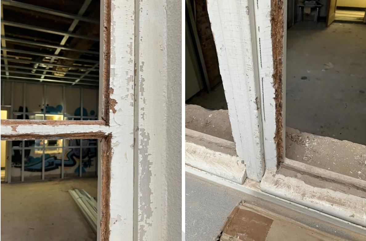
Foto's: het houten draaideel wordt gereed gemaakt voor het plaatsen van dun dubbel glas
