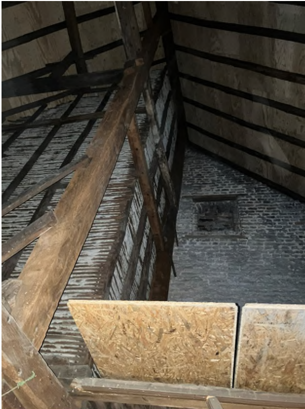
Foto: een lichtschacht op zolder precies boven het trappenhuis. In het dak was ooit een dakraam dat voor licht zorgde in het trappenhuis. Door dit bestaand element, kon in de plannen een nieuw dakraam geplaatst worden.
