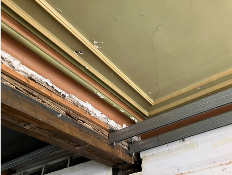
Foto: moerbalk ontdaan van pleisterwerk en een polychroom geprofileerd plafond
