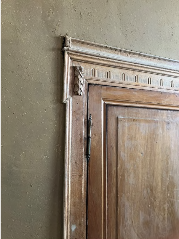
Foto: bovenhoek architraaf betimmering binnen kozijn en paneel deur onbehandeld
