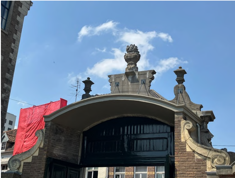
Foto: achterzijde ornament waarbij te zien is dat het ornament constructief gesteund wordt.
