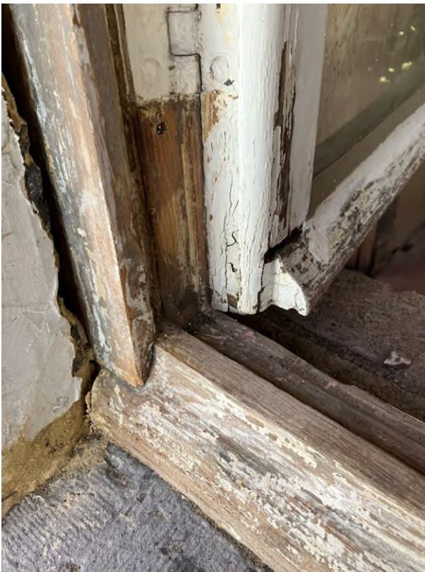
Foto: houten raam en raamdorpel tijdens uitvoeringswerkzaamheden
